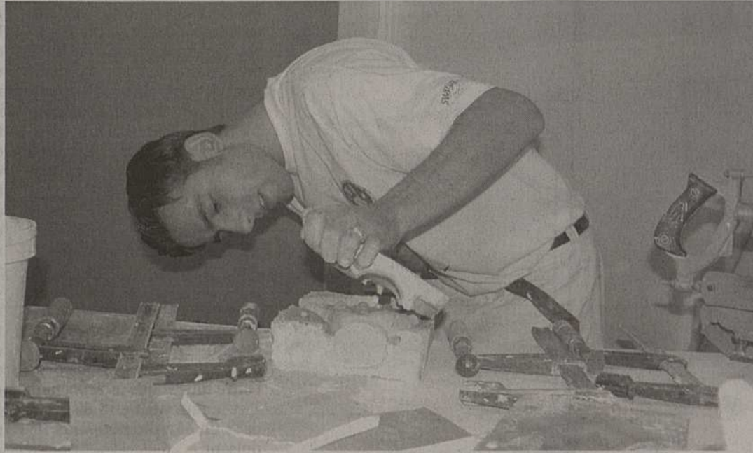
Des démonstrations permettent aux visiteurs d'en savoir davantage sur les métiers de plâtrier, de peintre et de réalisateur publicitaire.
